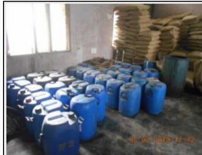
Non-conformité : pas de deuxième contenant pour les produits chimiques
